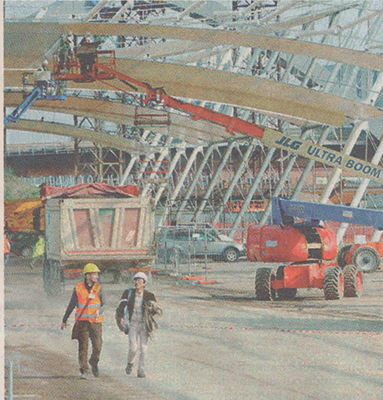
I lavori per la costruzione dei padiglioni dell'Expo di Milano 2015
